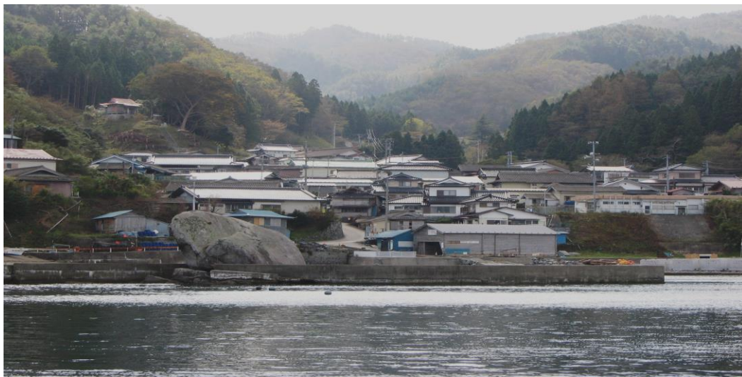
(「わかた」の元加工場周辺・写真中央手前)
